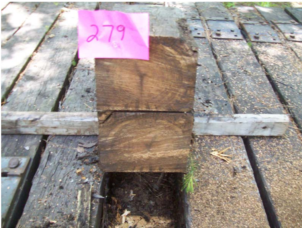
Figure 58 - Tie #279 (Koppers/red oak/P2 creosote).
